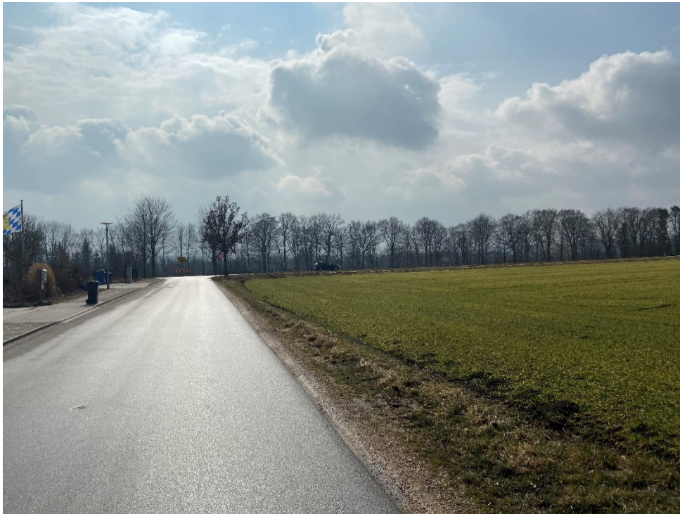
Abb. 18: Ansicht von Norden - Gemeindeverbindungsstraße, Ackerfläche; (Foto Jocham + Kellhuber, März 2021)
