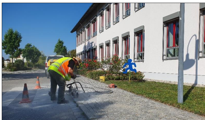
Mit dem Abfräsen der Bordsteinkante soll auch auf der Schulhausseite ein behinderten gerechter Übergang erreicht werden.
