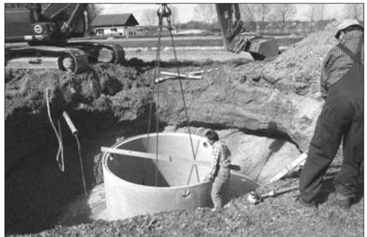
**In Eigenleistung eine technische Erweiterung der Kläranlage geschaffen: Einbau der Brauchwasser-Zyste**
