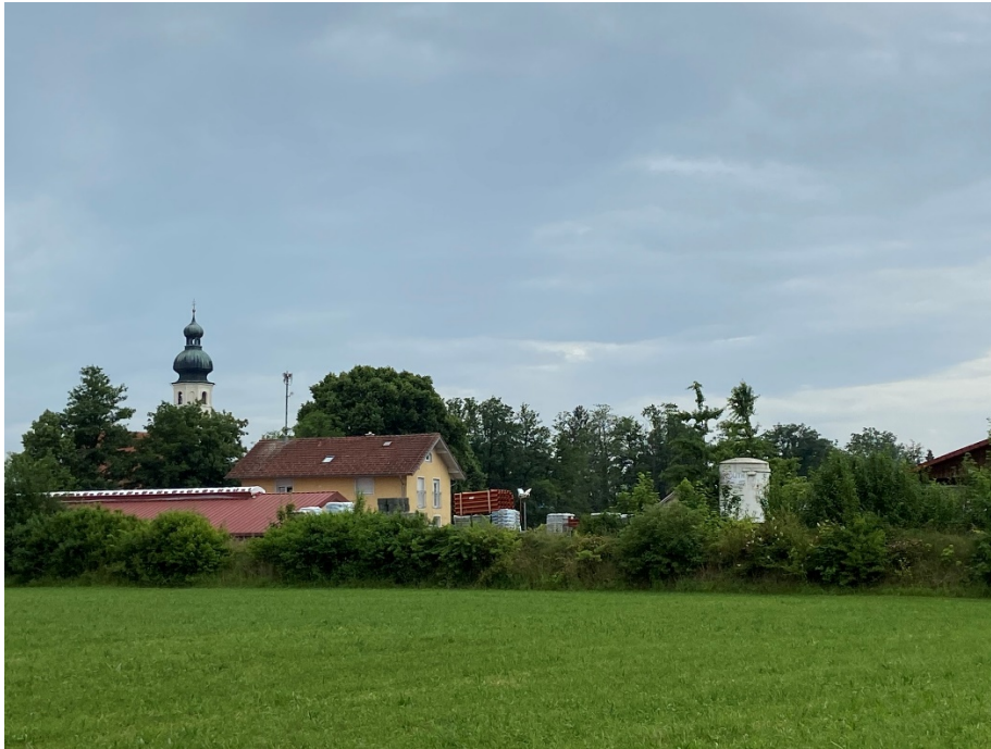
Abb. 23: Ansicht von Osten – Lärmschutzwall entlang Geltungsbereichsgrenze; Foto Jocham + Kellhuber (Juni 2022)
