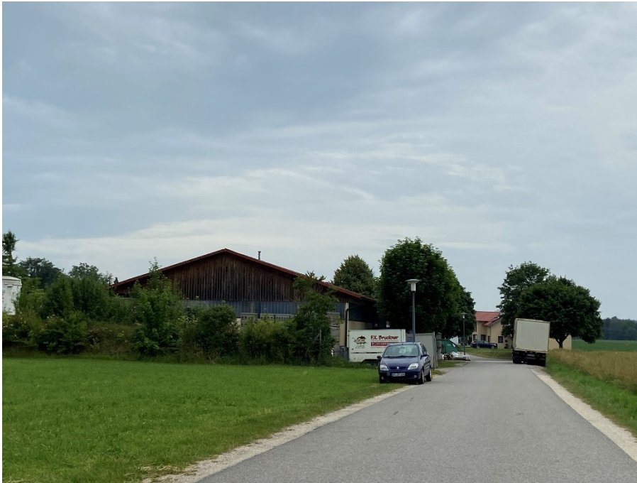
Abb. 3: Ansicht von Osten – Freiherr-von-Ow-Straße mit Lagerhalle; Foto Jocham + Kellhuber (Juni 2022)
