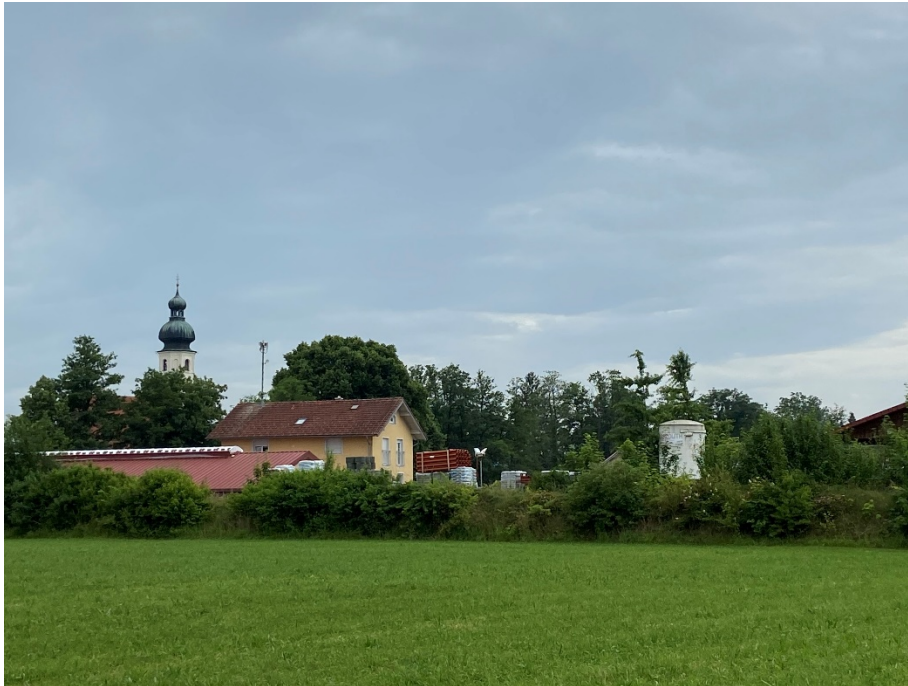
Abb. 7: Ansicht von Osten – Lärmschutzwall entlang Geltungsbereichsgrenze; Foto Jocham + Kellhuber (Juni 2022)
