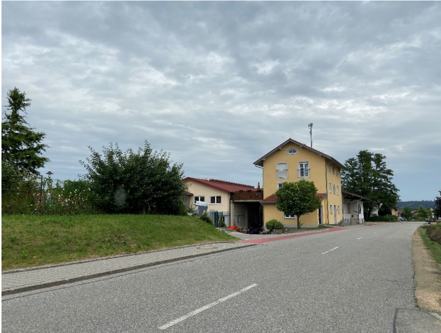
Abb. 5: Ansicht von Nordwesten – Marktler Straße Haus-Nr. 6a (Wohnen); Foto Jocham + Kellhuber (Juni 2022)
