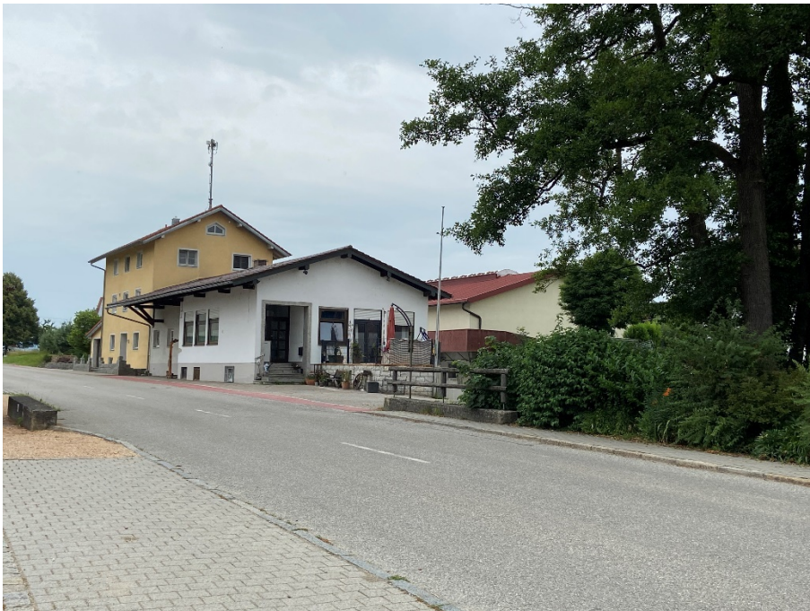
Abb. 6: Ansicht von Südwesten – Marktler Straße Haus-Nr. 6 + 6a (Wohnen + Gewerbe); Foto Jocham + Kellhuber (Juni 2022)
